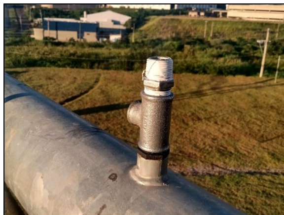
Figura 12 - Conexión del tee de reducción y del nipple del sensor de presión al tubo del pivote.
