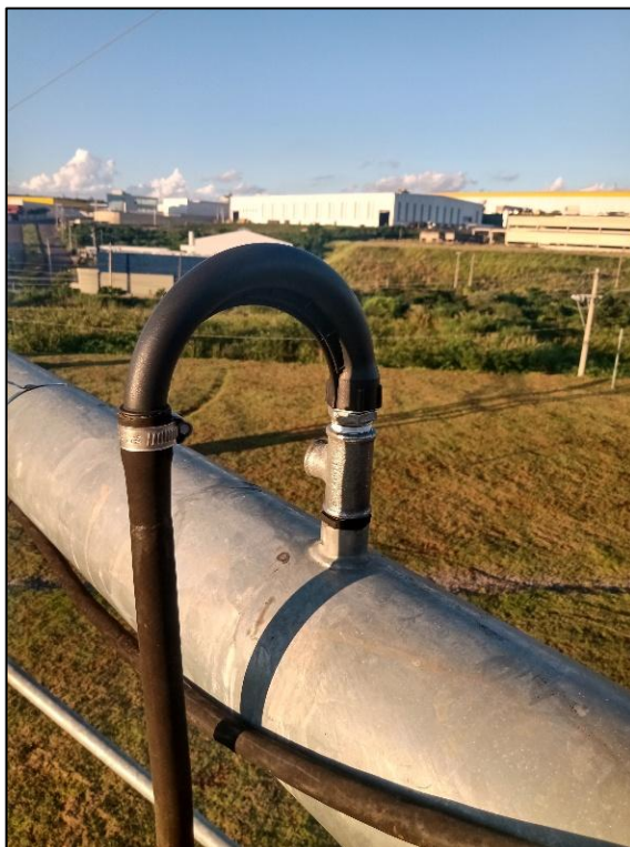
Figura 13 - Conexión de la curva del aspersor al nipple.
