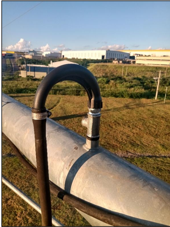
Figura 19 - Conexión de la curva del aspersor al nipple.
