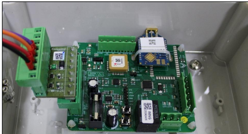
Figura 56 - Instalación del nuevo Shield en la placa Imanage.
