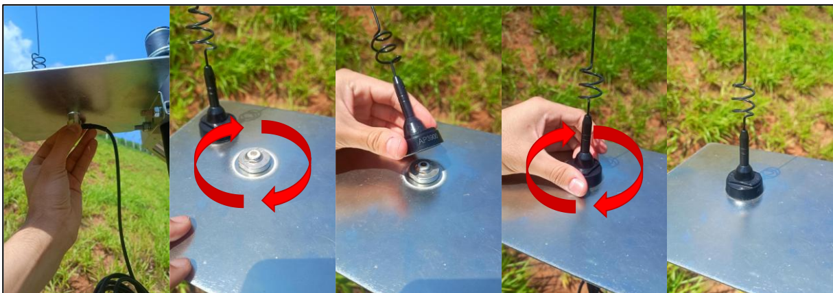
Figura 7 - Instalación de la antena sobre el soporte.
